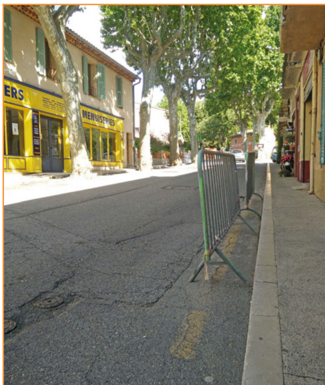
La rue Ambroise Croizat avant les travaux.
