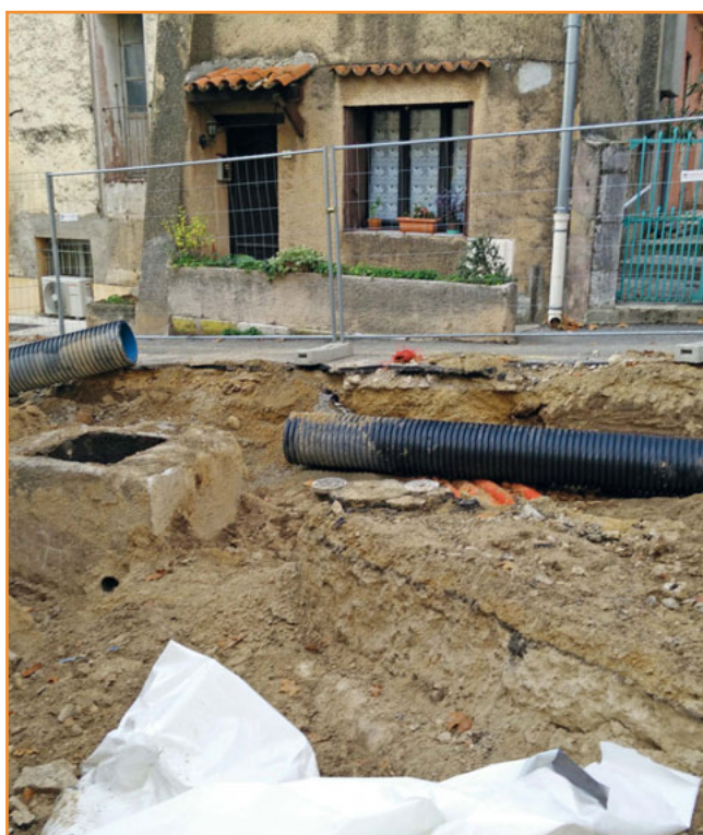
Les réseaux d'eau et d'assainissement en cours de rénovation.
