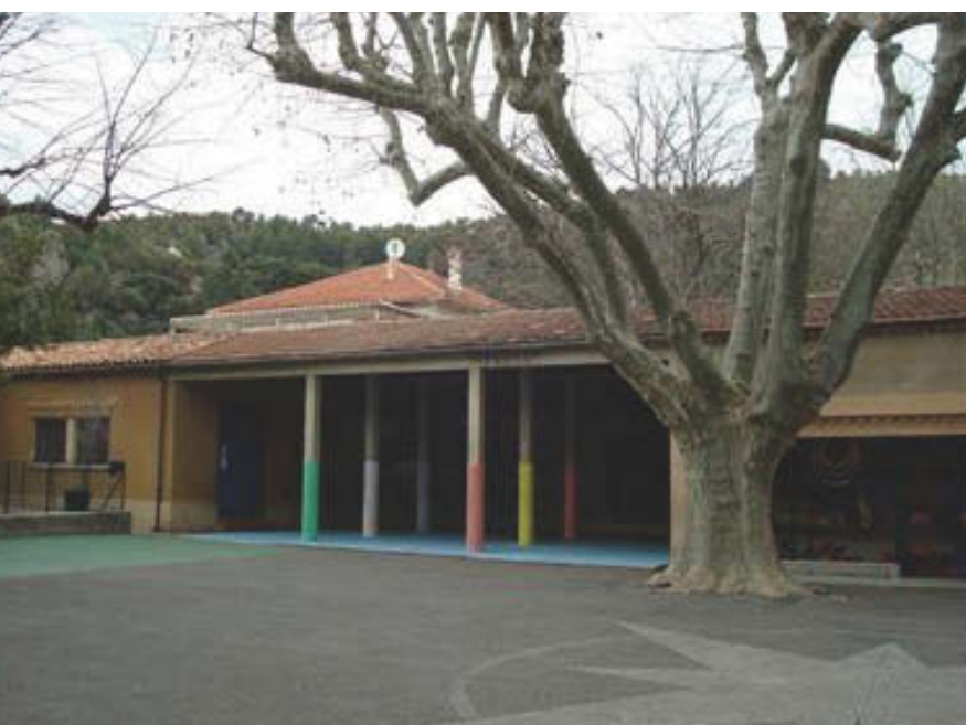
La cour avant les travaux
