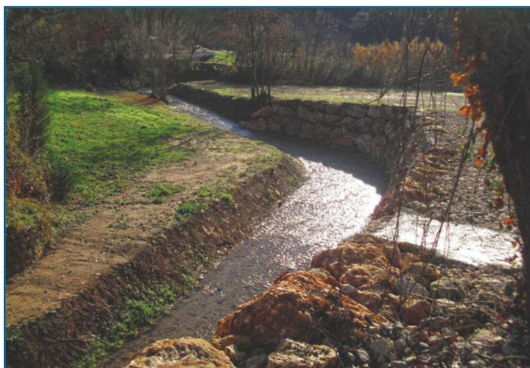
*L'enrochement réalisé sur la vieille route d'Entrecasteaux.*
