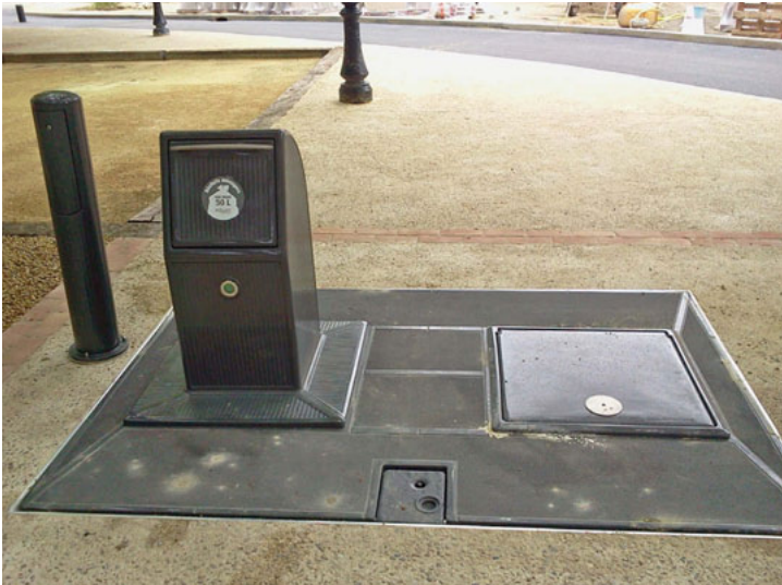
Les poubelles enterrées, mai 2013.
