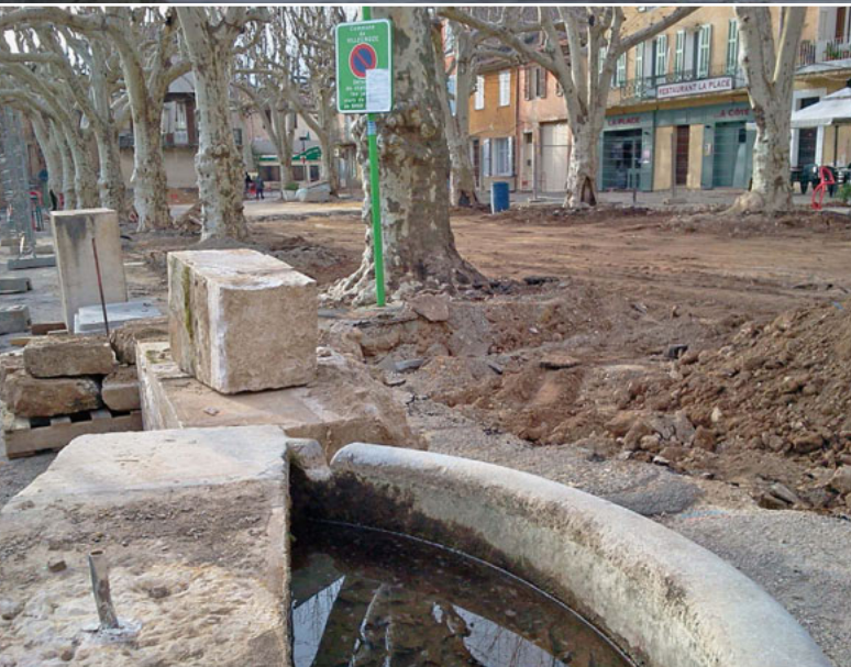
Au premier plan, la fontaine démontée, décembre 2012.
