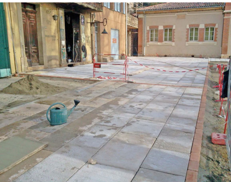
Le dallage en cours côté commerçants, mars 2013.
