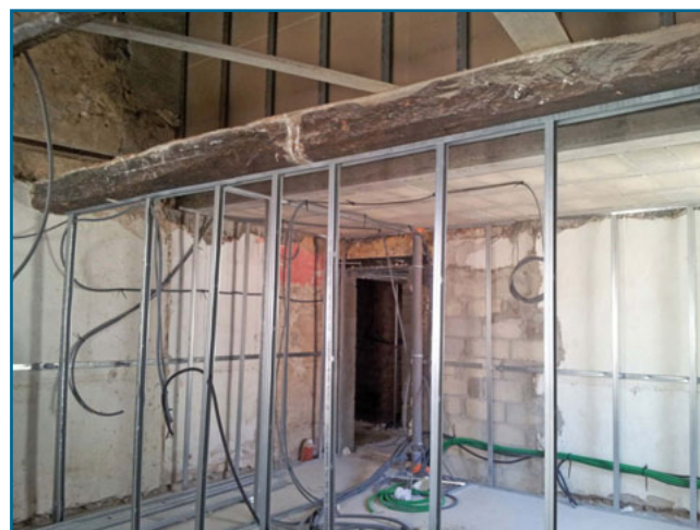
Plancher en cours de réfection au 2 e étage.
