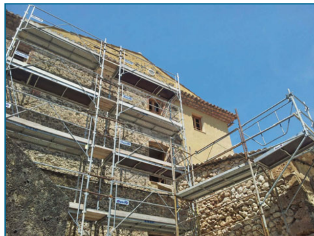
La maison Roere en cours de réhabilitation.
