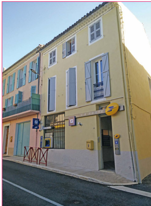
Après les travaux.
