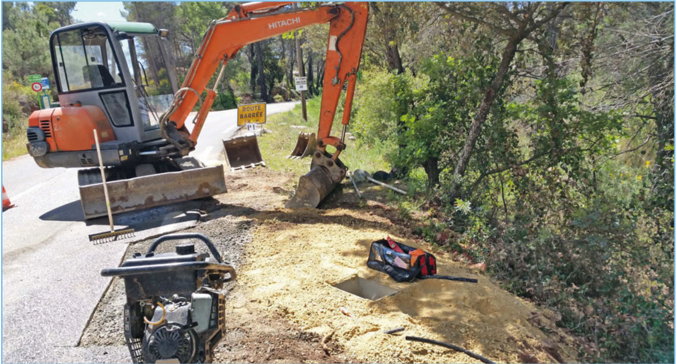
Travaux sur la RD 557 pour un branchement individuel neuf.
