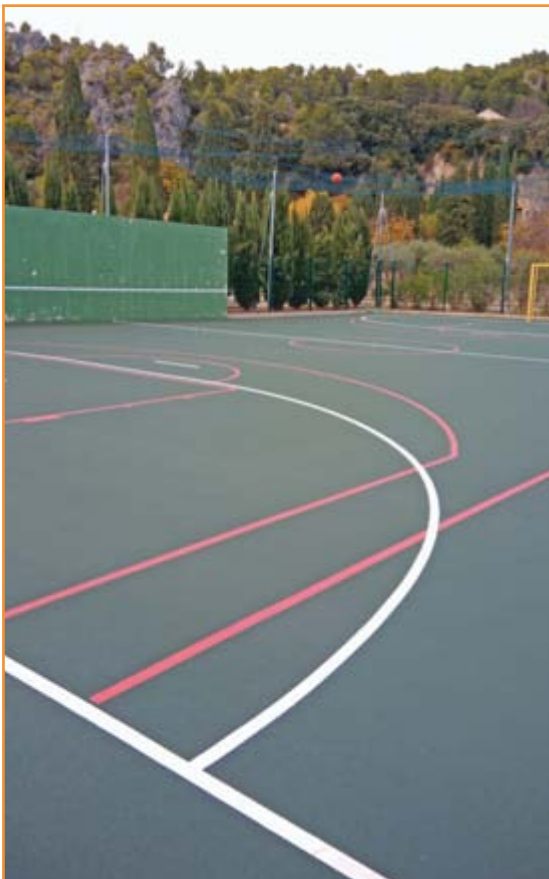
Revêtement et marquage au sol renouvelés.
