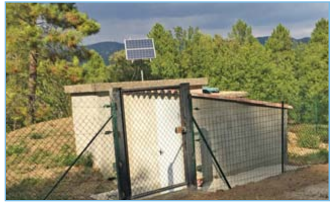
Le local des Hubacs avec son panneau solaire.
