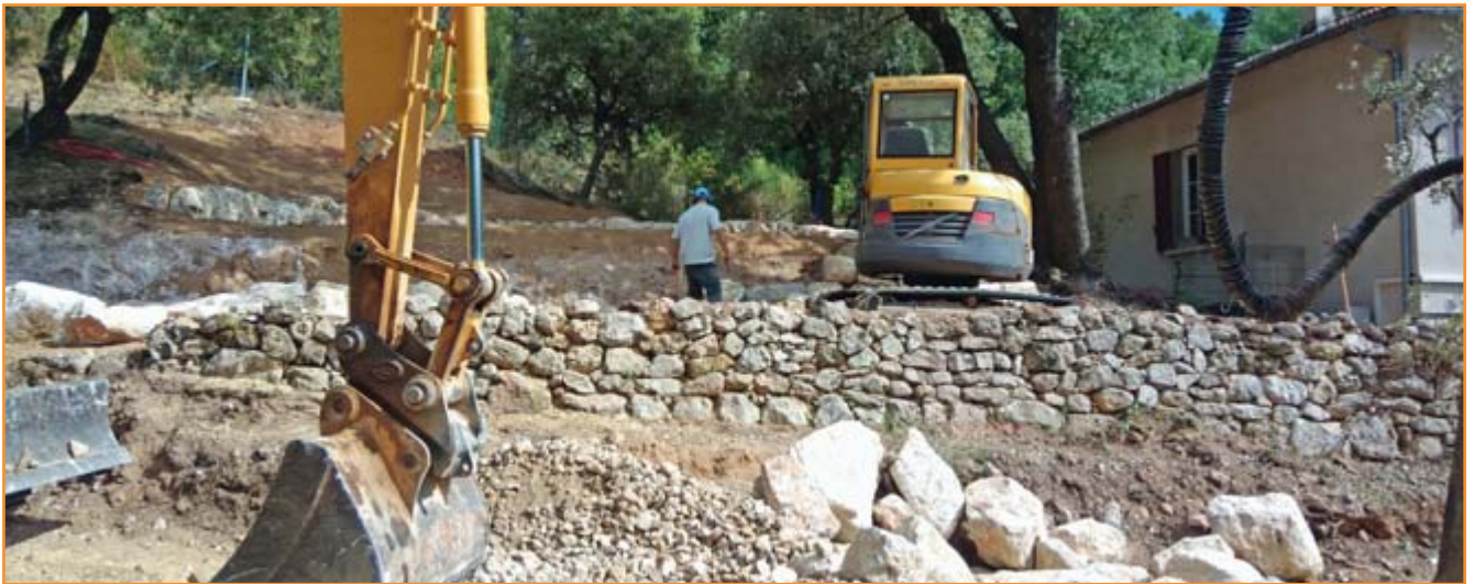
Les travaux de terrassement ont donné forme au jardin de lecture.
