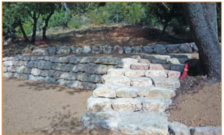
Les travaux de terrassement pour le jardin de lecture de la bibliothèque.
