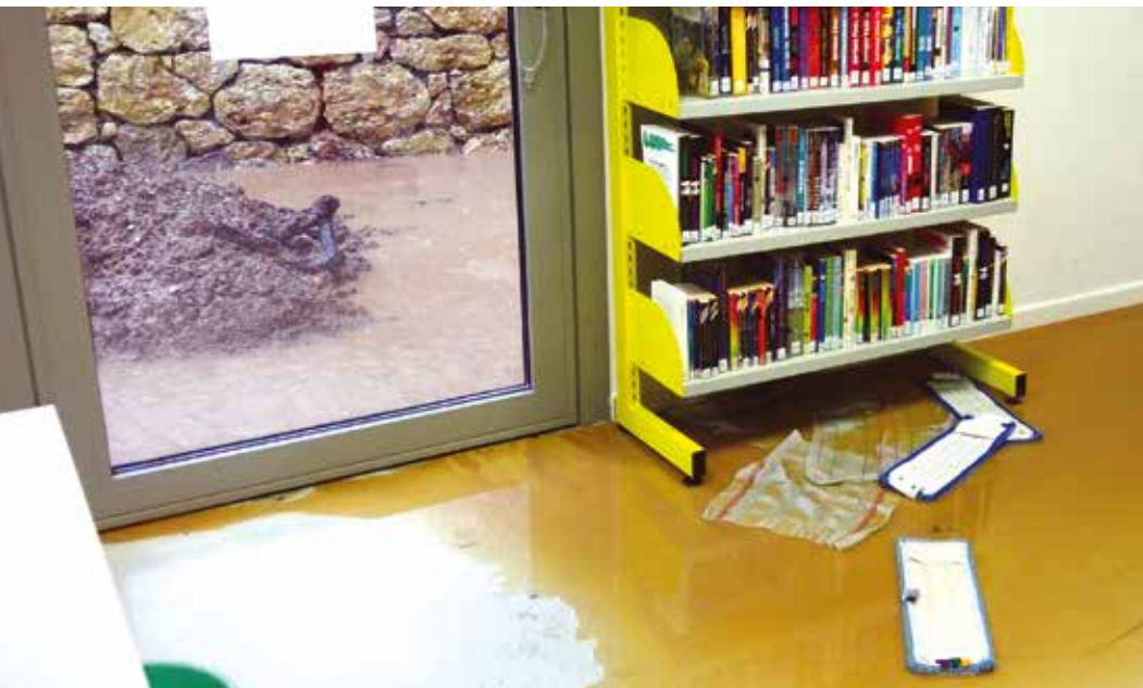
Inondation en avril 2018 à la bibliothèque municipale
