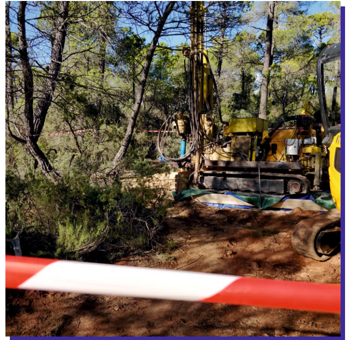
Travaux du BRGM pour l'installation d'une sonde
