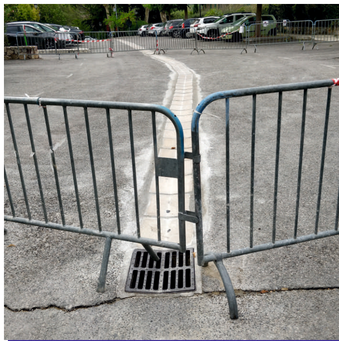
Caniveau en cours de réfection sur le parking Rampal
