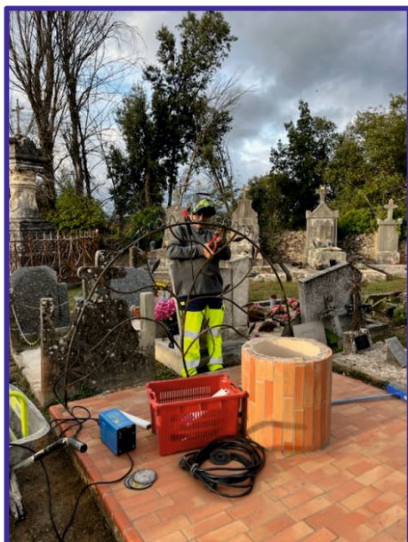
Travaux en cours pour...
