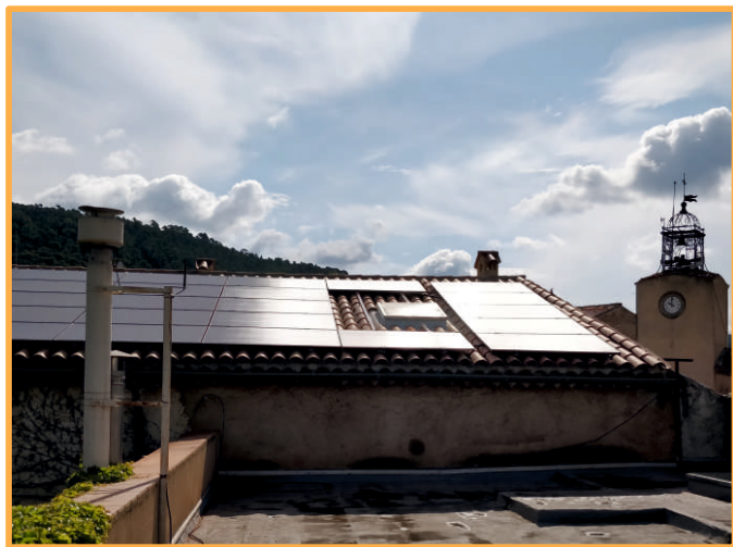
Des panneaux bien exposés sur le toit de la mairie
