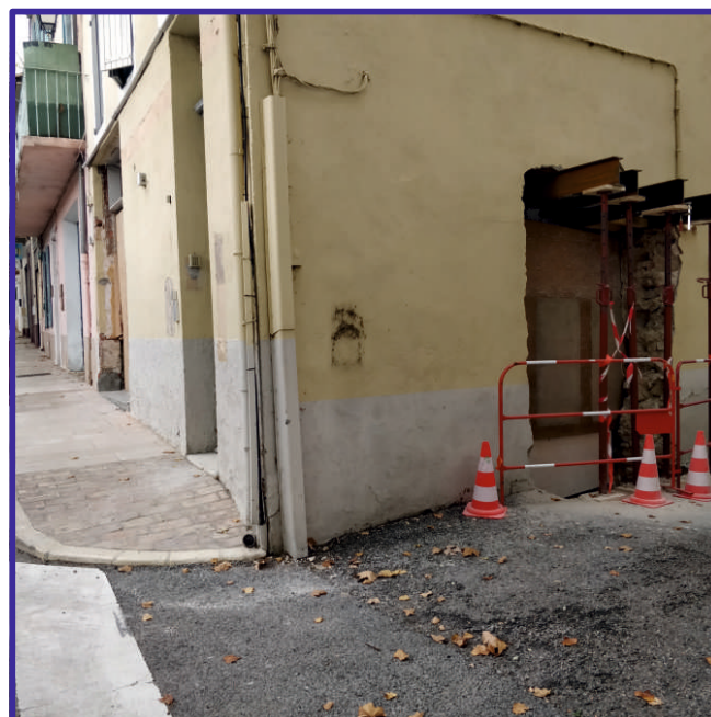
Travaux pour le déplacement du DAB, novembre 2025
