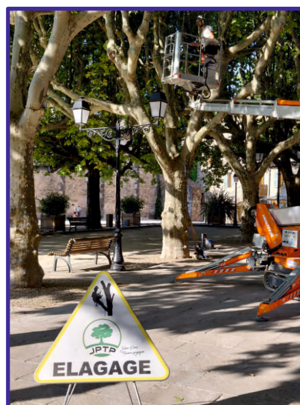
Elagage en cours sur la place
